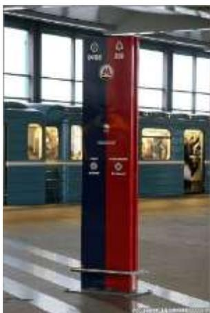
На всех станциях Московского метрополитена установлены специальные колонны экстренного вызова, которые предназначены для связи пассажиров с Ситуационным центром. С их помощью можно сообщить об экстренной ситуации. Кроме того, пассажир может обратиться к дежурному по станции. Все устройства связи переключены на Ситуационный центр.
